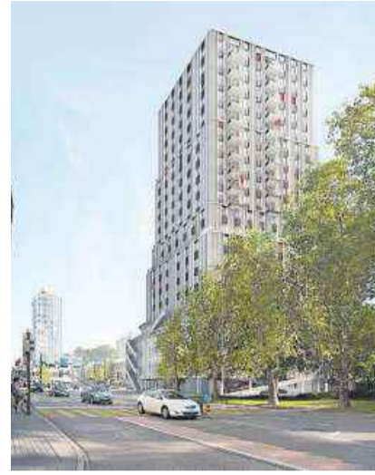
Kompakt, aber mit einem (zu) grossen Parkhaus im Sockel: «Monroe» der Zürcher Architekten Romero Schaeffe.
